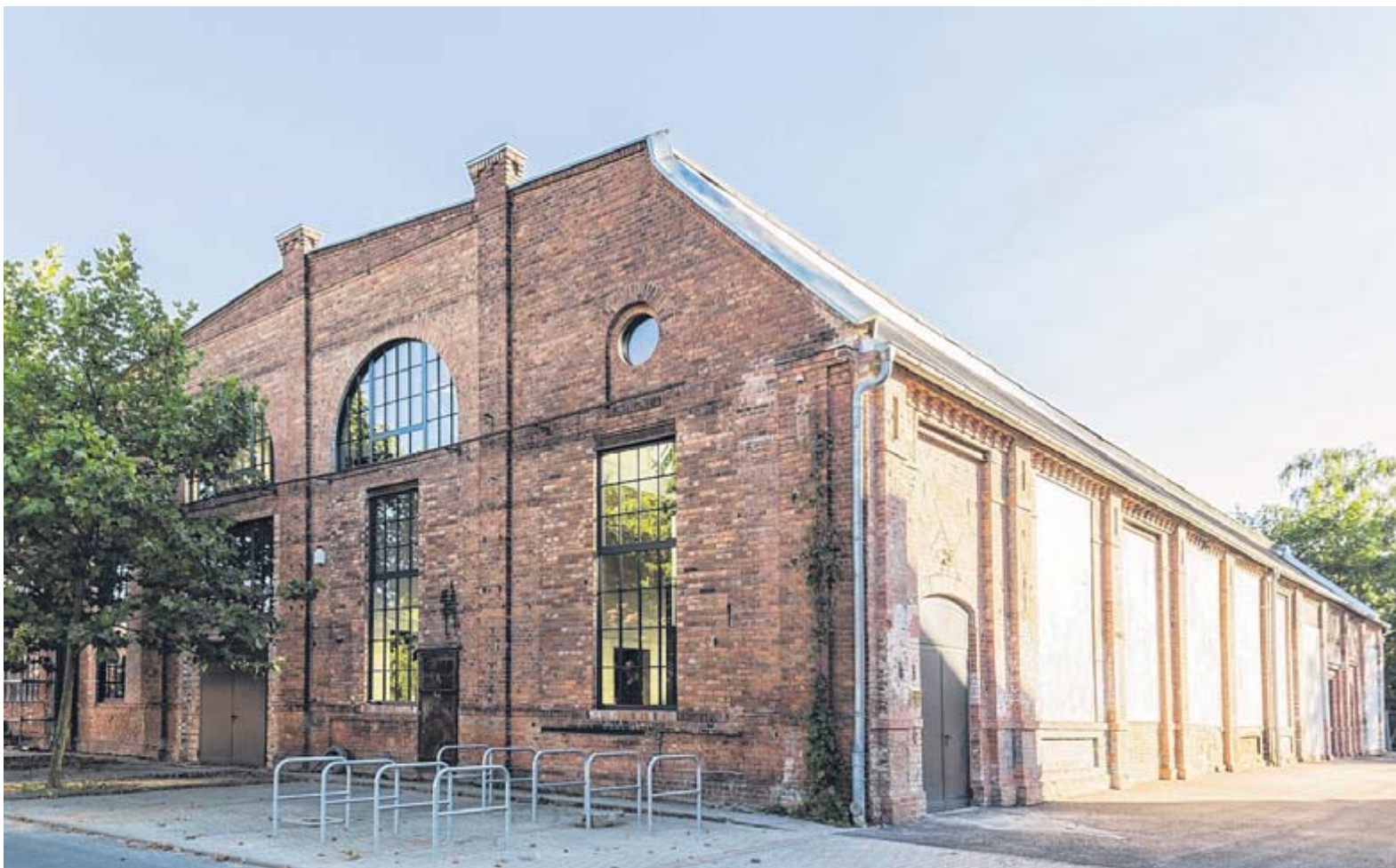
Stein um Stein: In dieser denkmalgerecht sanierten Industriehalle lagert Rammstein Fanartikel und Instrumente.
